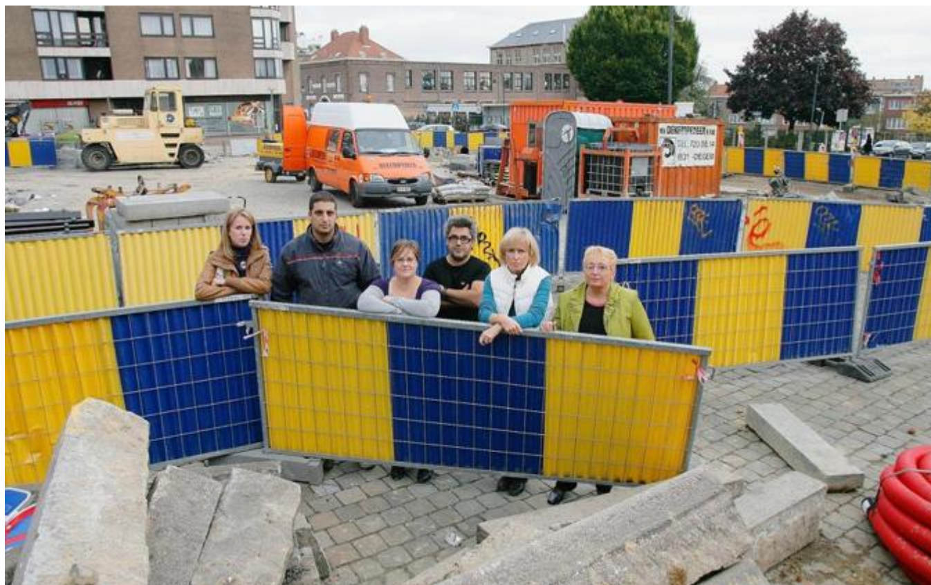
"Ils ont ouvert les deux rues enlaçant la place alors qu'ils devaient travailler par phase, un côté puis l'autre. Pour terminer par le centre de place."
